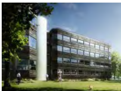
Plusenergihuset Powerhouse i Sandvika, Norge, nu utrustat med UltraLink.
